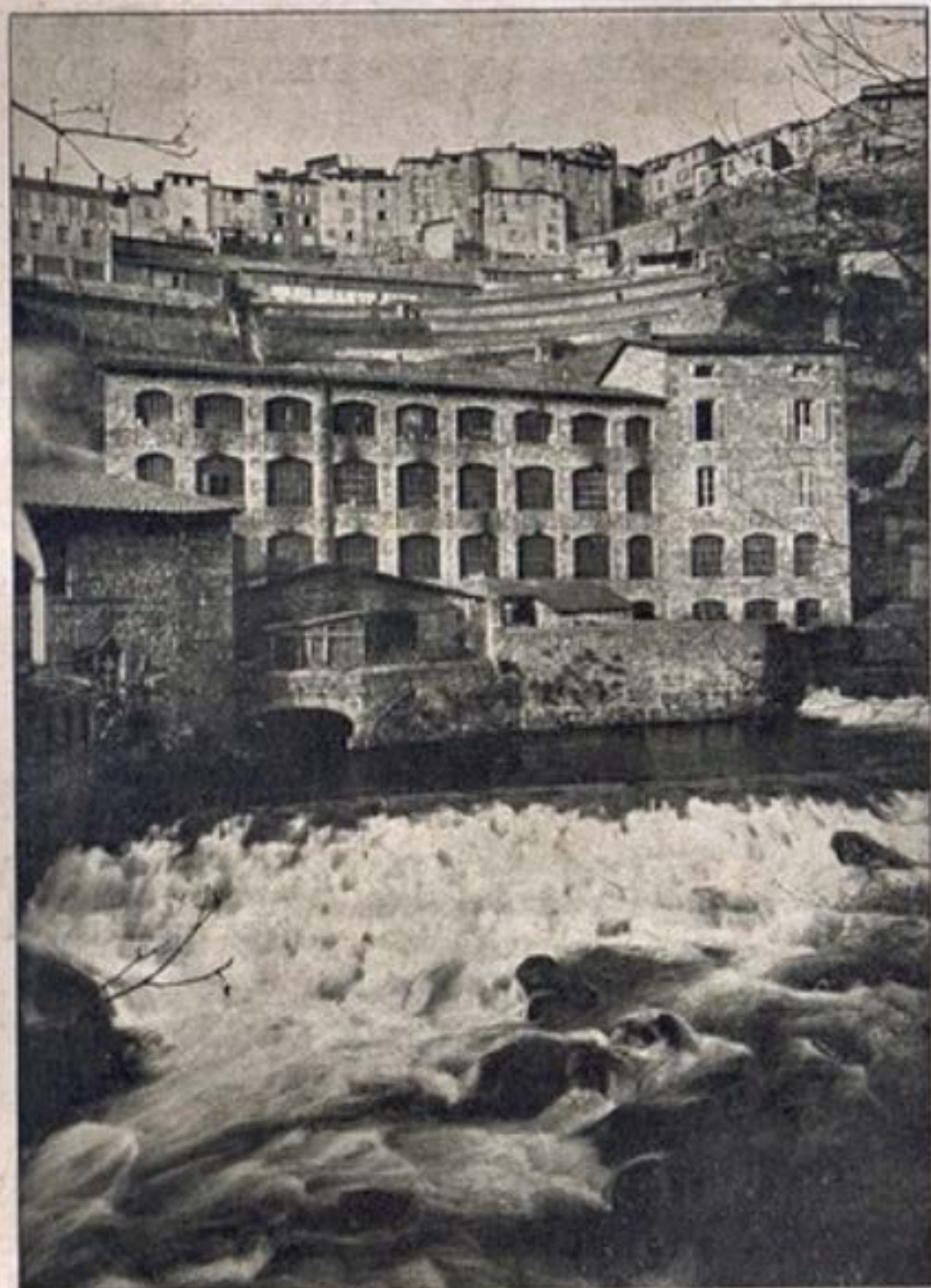
Vue de l'Usine du Faux-Martel
